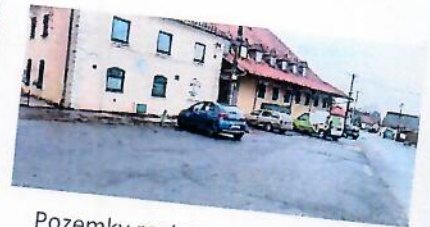
Pozemky registra „C“ KN parc. č. 81/3, 81/5 a 81/6 so spevnenými asfaltovými plochami, v pozadí budova súp. č. 83 na pozemku registra „C“ KN parc. č. 81/2
