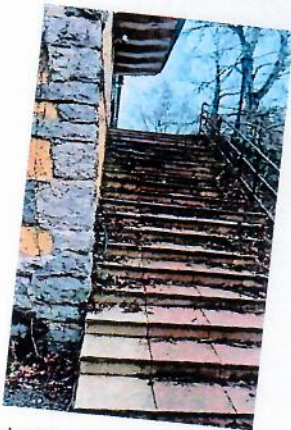
Vonkajšie schody na pozemku registra „C“ KN parc. č. 81/1
